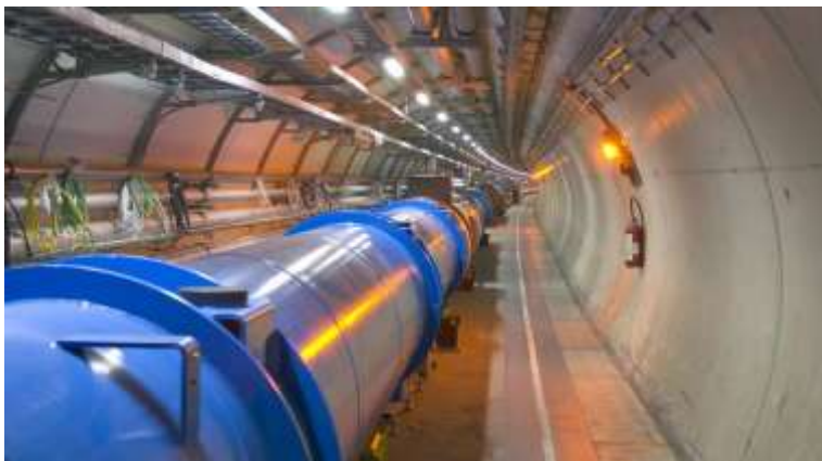
Figura 2. Imagine a interiorului tunelului acceleratorului, la 100 de metri sub pământ.
